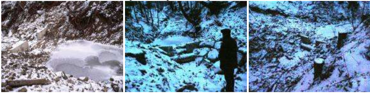
Zemné hrádze v rokline v lese postihnutom kôrovcovou kalamitou (Oščadnica).
